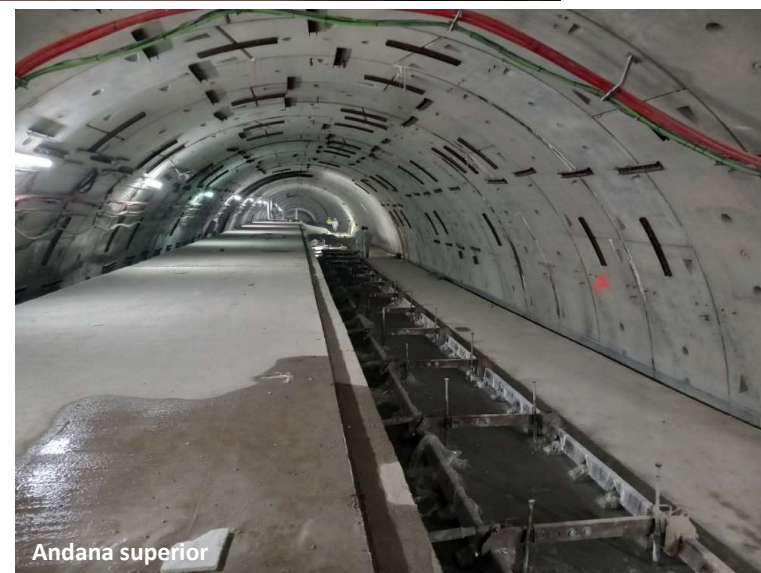
Estructura connexió pou-túnel
